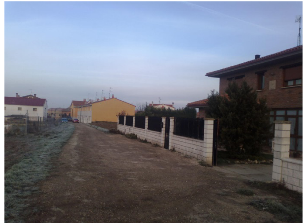
Vivienda en SRC con acometidas urbanas
